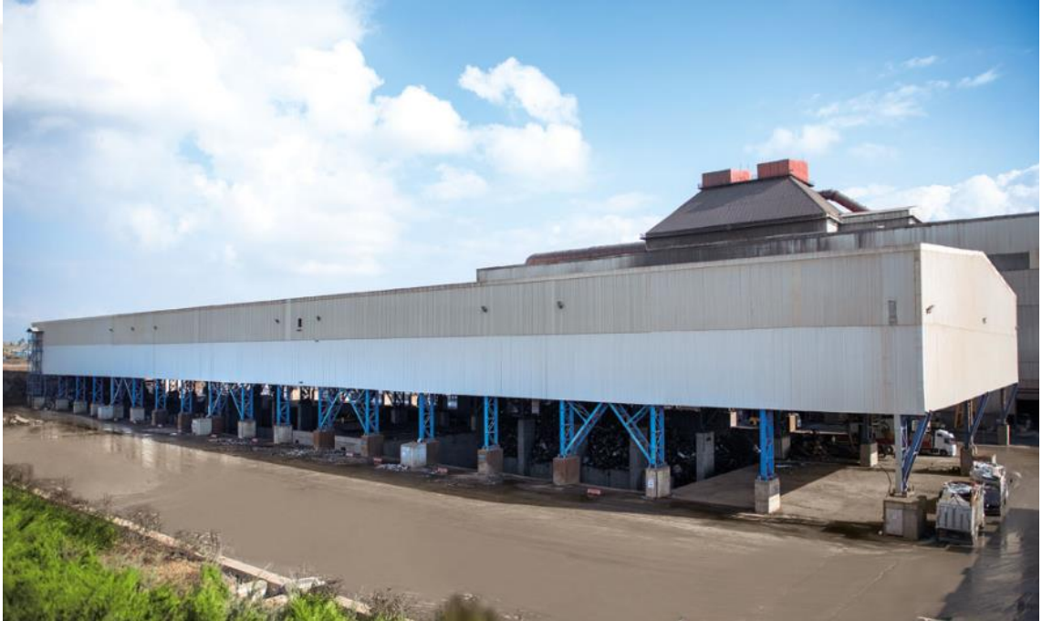
Şekil 7.2. Tesisin hurda depolama sahasından görünüm [78]
