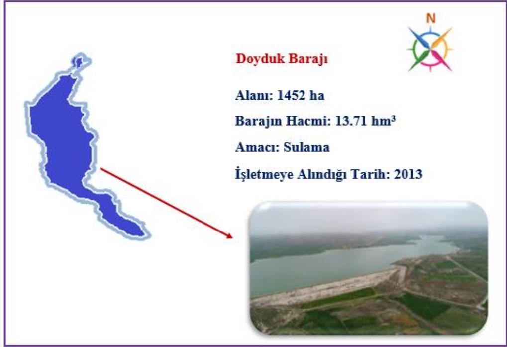
Şekil 6.22. Doyduk Barajı'nın genel görünümü
