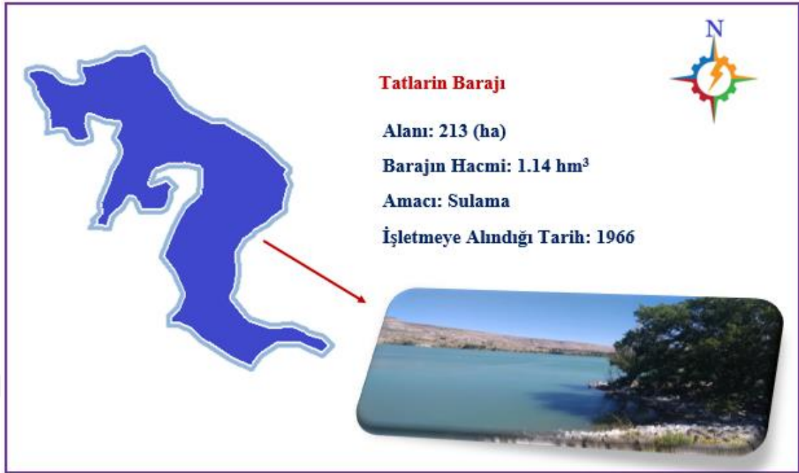
Şekil 6.10. Tatlarin Barajı'nın genel görünümü
