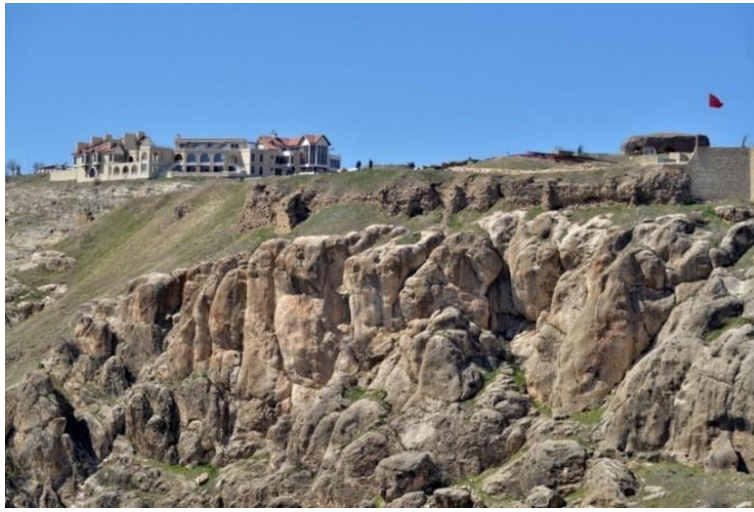
Foto. 2: 2017 Yılı Harput İç Kale Güney Sur Duvarı Restorasyon Çalışmaları Öncesi Görünümü
