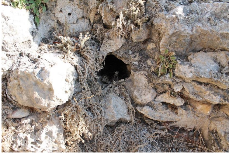
Foto. 4: Güneydoğu burç su kanalı (F: B. Duyar, 2020)
