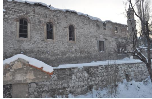
Foto. 9: Kuzey cephe (Yılmaz, 2019)25
