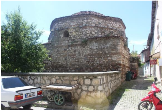
Foto. 14: Hamamın diğer görünüşü
