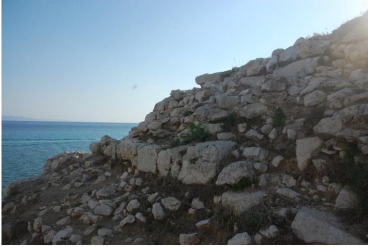
Foto. 5. Surların temel kısmında büyük blok taşlar kullanımı (İ.H. Kurtuluş, 2018)
