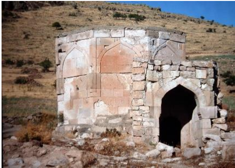
Foto. 5: Turasan Dede türbesi, kuzey batı cephesinden görünüşü (B. Deniz, 2002).
