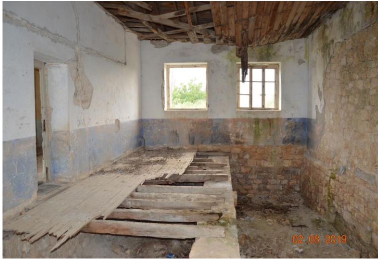
Foto. 10: Örenköy İlkokulu Derslik
