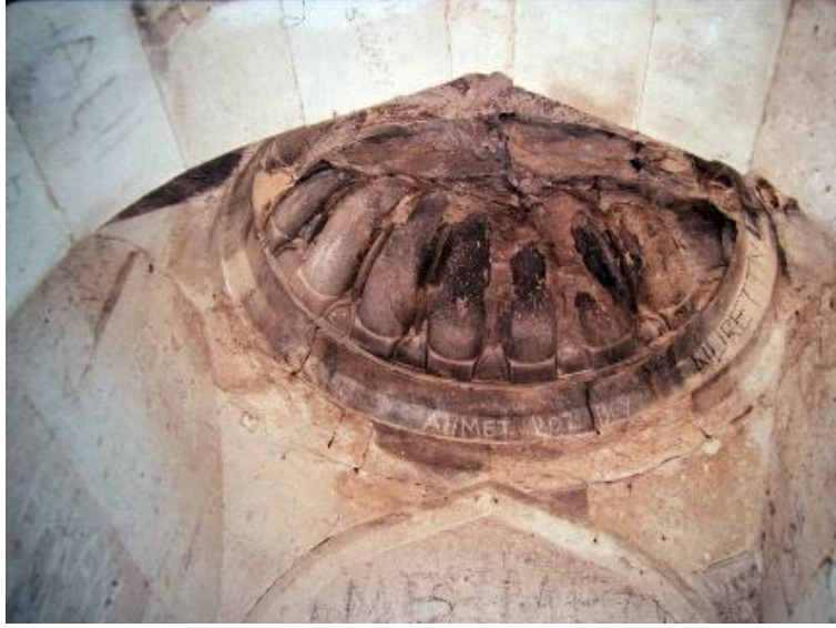
Foto. 8: Turasan Dede türbesi, girişteki ön mekânın üst örtüsü (batı) (B. Deniz, 2002).
