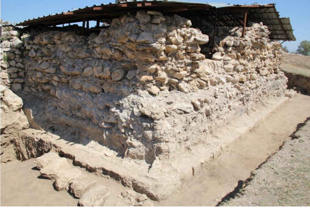
Foto. 11: Köşklü Hamam'ın köşk bölümünün doğu ve güney cephesi.
