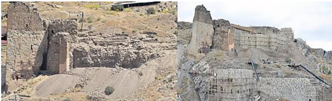
Foto. 10: Harput İç Kale güney sur duvarı restorasyon öncesi ve sonrası (2. Bölüm)
