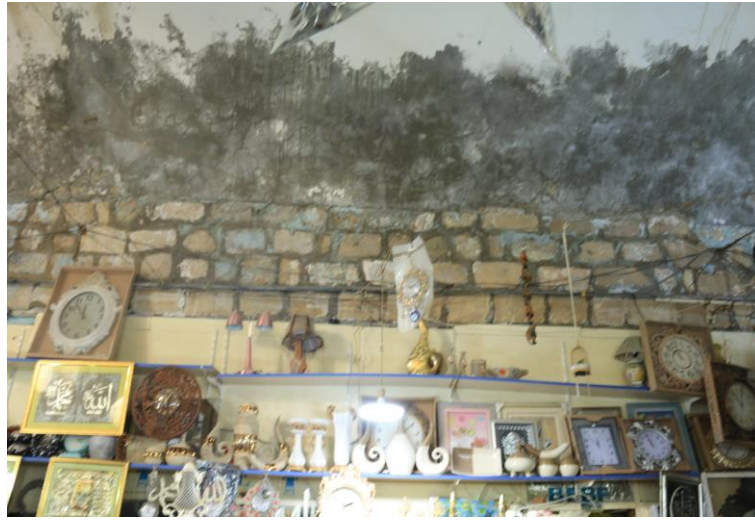
Foto. 3 Kuzey kanatta müdahale gören duvar
