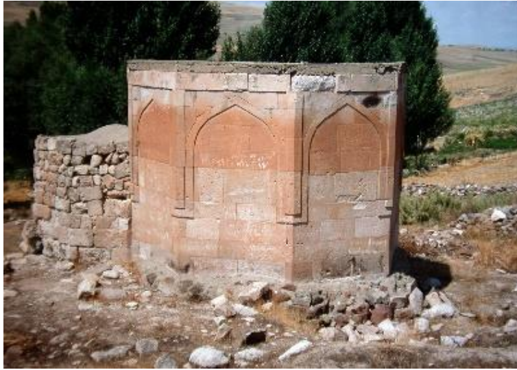
Foto. 4: Turasan Dede türbesi, doğu cephesinden görünüşü (B. Deniz, 2002).
