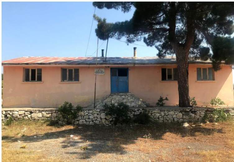
Foto. 7: Gündüzler Köyü İlkokulu Güney Cephe Giriş Merdivenleri
