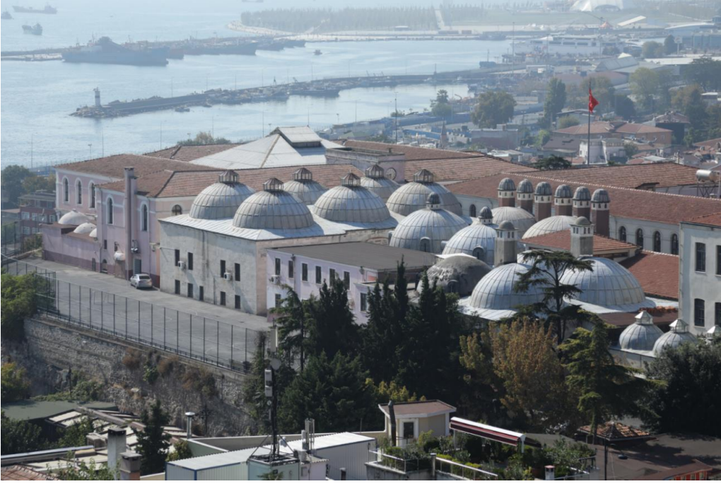
Foto. 3: Sultan Ahmed Külliyesi Darüşşifa yanındaki hamam yapısı (Aras Neftçi Arşivinden).
