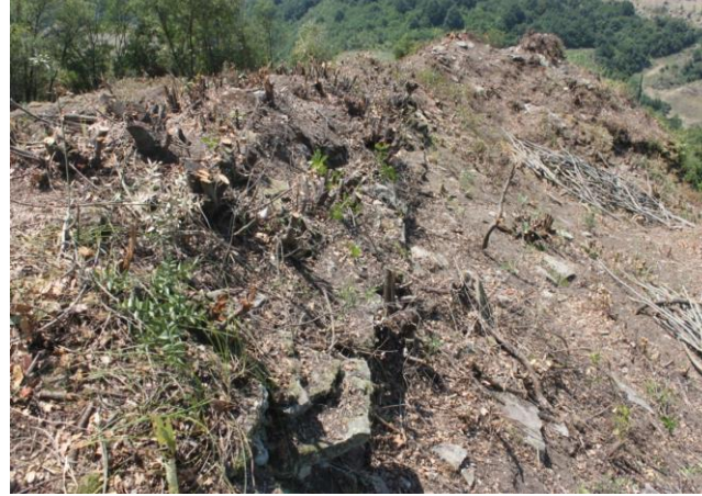
Foto. 6: Kuzey cephede temizlik sonrasında surun görünümü
