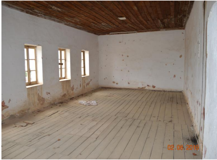
Foto. 13: Çaltıbozkır Köyü Çaltı İlkokulu Güney Derslik
