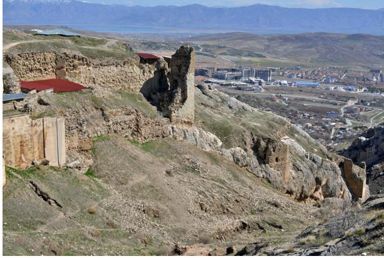
Foto. 5: 2016 Yılı Harput İç Kale batı sur duvarlarının restorasyon öncesi görünümü
