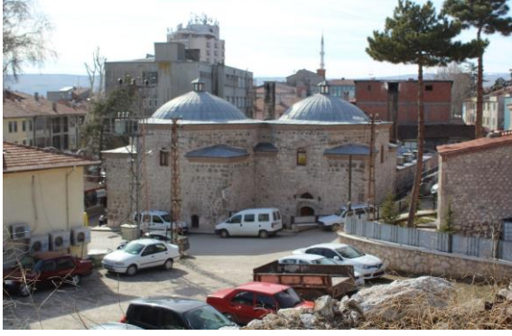
Foto. 2: Hamamın diğer görünüşü
