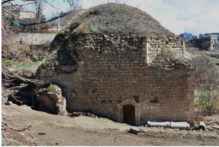
Foto. 10: Batı cephedeki kapı
