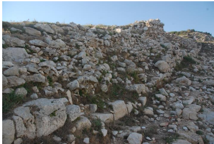
Foto. 15: Doğu surunun doğu cephesinin genel görünümü (İ.H. Kurtuluş, 2018)
