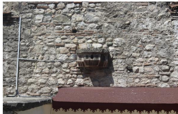
Foto. 15: Giriş cephesindeki kuş evi görünüşü
