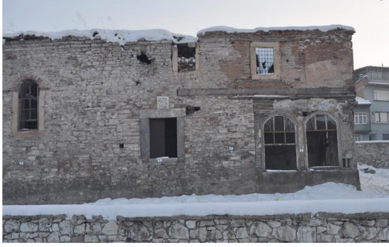
Foto. 12: Kuzey cephe (Yılmaz, 2019)
