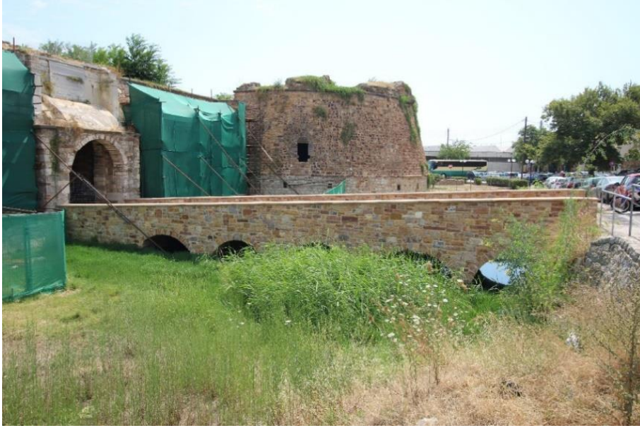
Foto. 9: Porta Maggiore önündeki köprünün yenileme sonrası görünümü.
