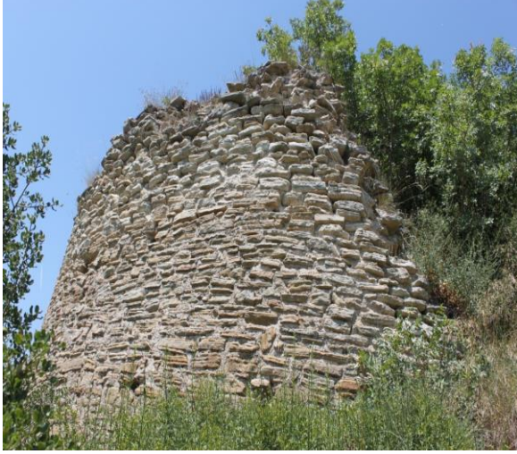
Foto. 7: Çobankale güney sur duvarında ortaya çıkan burç
