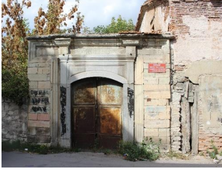
Foto 2: Bahçe kapısı dış ve iç görünümü, avlu
