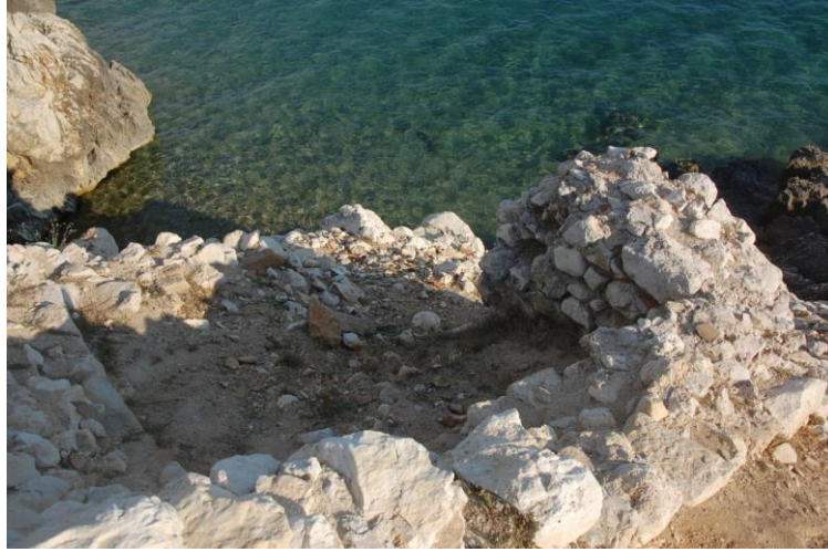
Foto. 13: Kalenin güneydoğu burcunun üstten genel görünümü (İ.H. Kurtuluş, 2018)
