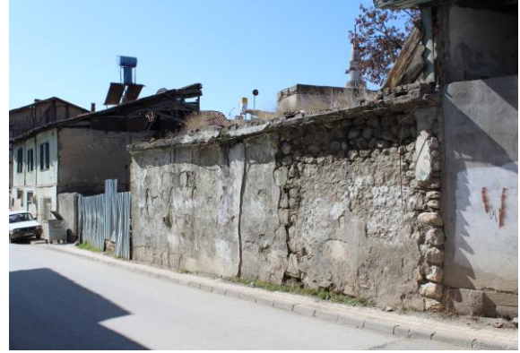
Foto. 30: Hamamın diğer görünüşü
