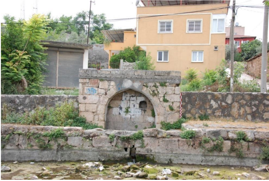
Foto. 1: Kurtkulağı çeşmesi genel görünüm
