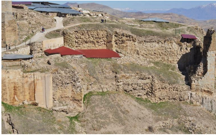
Foto. 7: 2016 Yılı Batı Surunda, Çubuk Bey ile Belek Burcu arasındaki çalışmaları öncesi görünümü
