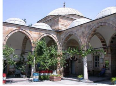
Foto 9: Nevşehir Damat İbrahim Paşa Medresesi dershanesi – avlu revakları ilişkisi (Çetinkaya, 2005)
