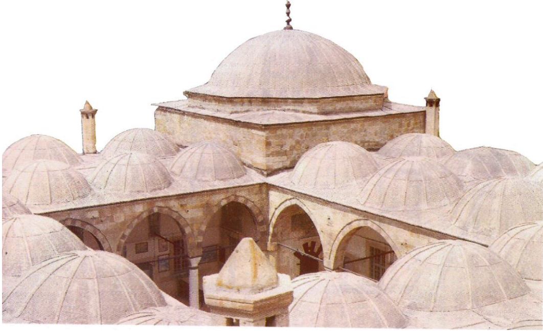
Foto. 3: Nevşehir Damat İbrahim Paşa Medresesi (Aktuğ -Kolay- 1993)
