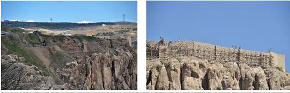
Foto 9: Güney sur duvarı, 2017 yılı restorasyon öncesi ve 2018 yılı restorasyon sonrası görünüm
