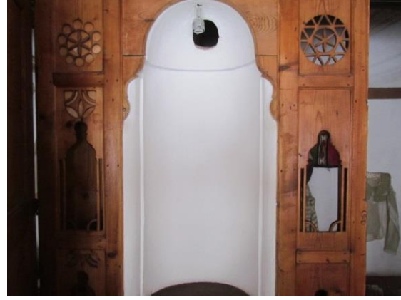
Foto. 2: Emincikler Konağı Restorasyon Sonrası (Muzaffer Karaaslan)
