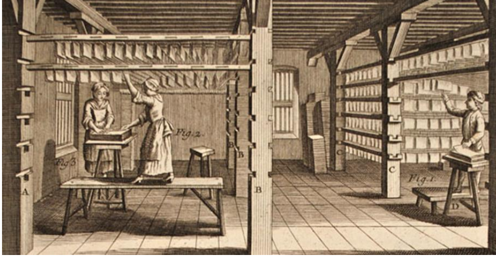
Çizim 3: Bir Avrupa kâğıdı üretim atölyesinde kâğıtların kurutulmasına ilişkin gravür (Barrett, 2011)
