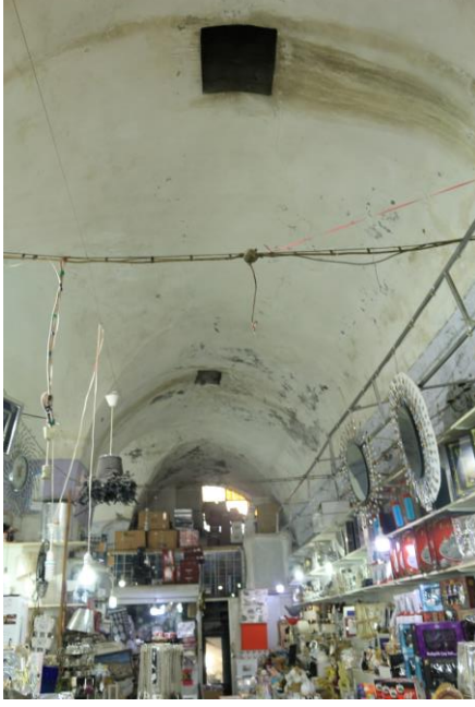
Foto. 12: Bedestenin tonoz sisteminde yer alan tepe pencereleri
