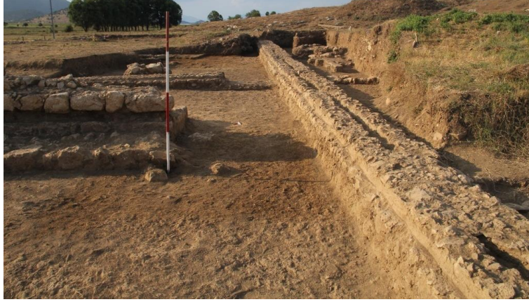
Foto. 20: 10 No'lu yapının güneyinde yer alan mekânlar arası irtibatı sağlayan açıklık.
