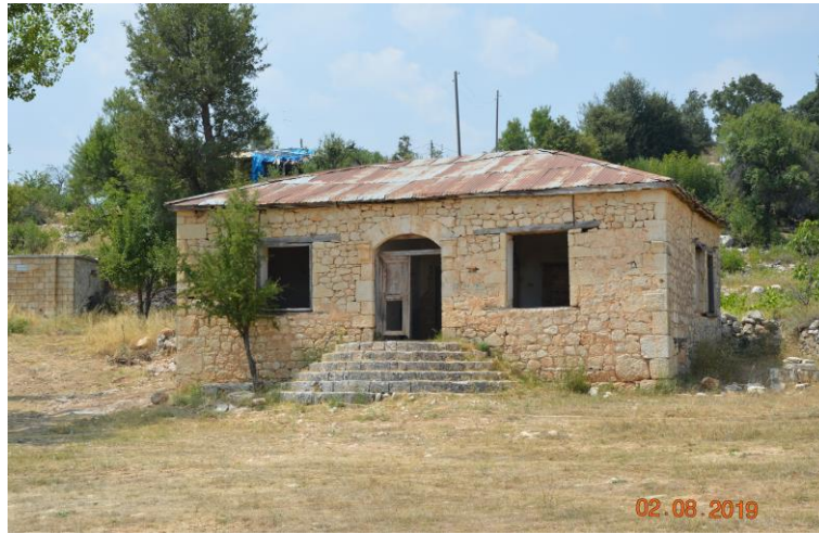
Foto. 9: Çaltıbozkır Köyü Sina İlkokulu Güney Cephe Giriş Merdivenleri
