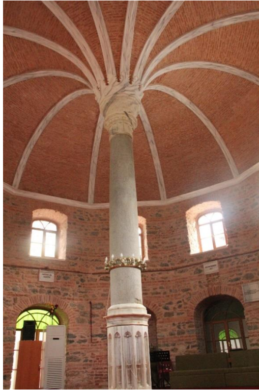
Şahkulu Sultan Meydan evi kubbe
