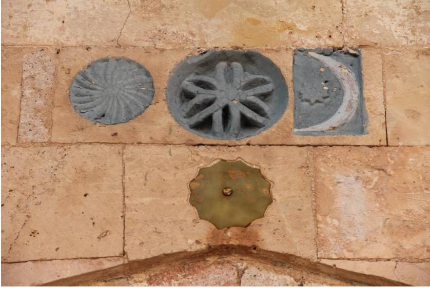
Kırklar meydanı giriş cephesi-taş bezeme
