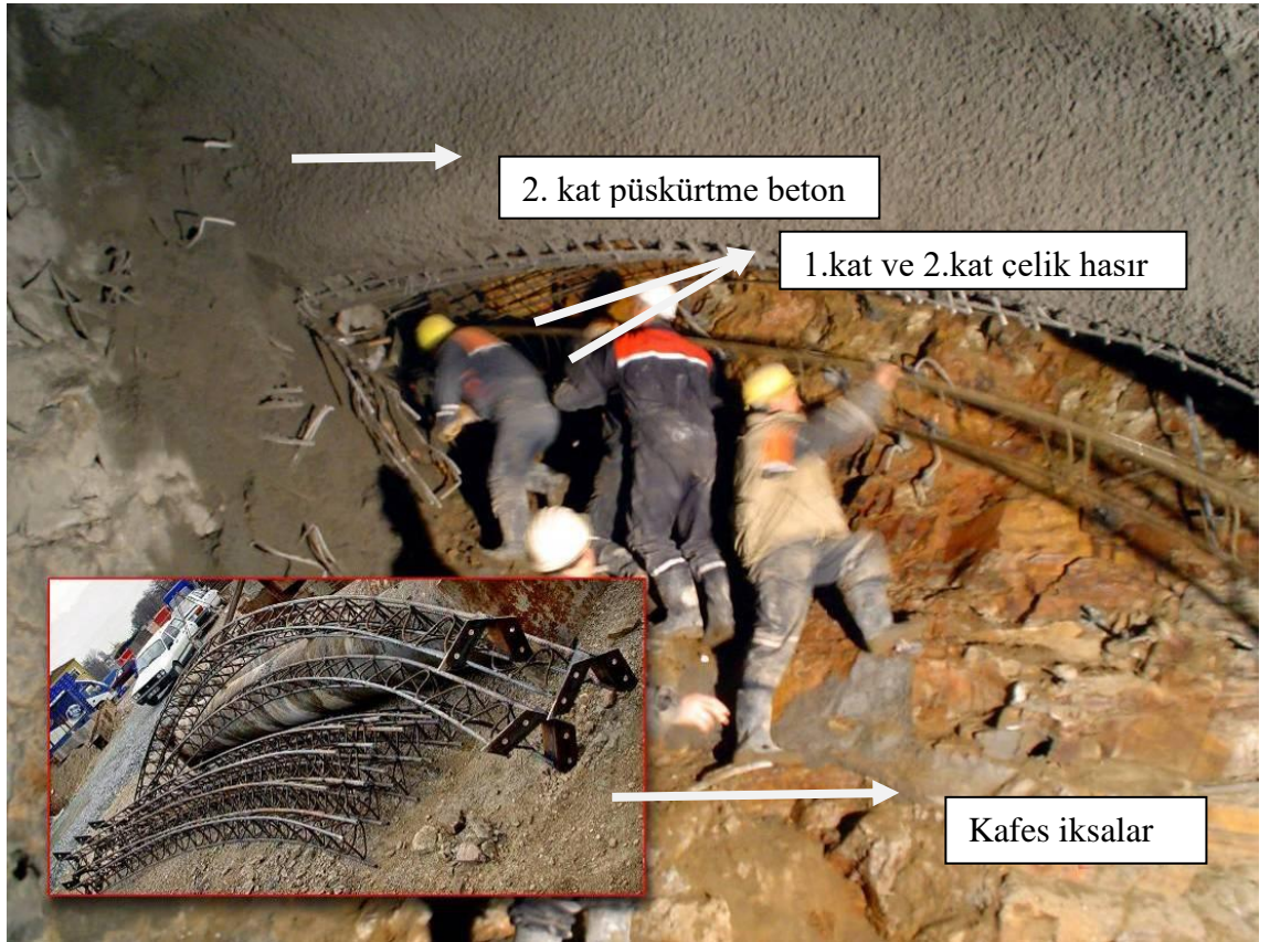
Resim 8.7. B 2 tip zeminlerde 1.kat çelik hasır, kafes iksa montajı, püskürme beton ve 2. kat çelik hasır ve püskürtme beton uygulaması
