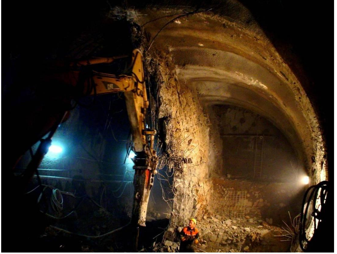
Resim 8.9. C 3 tip tnel zeminlerinde orta duvar uygulaması
