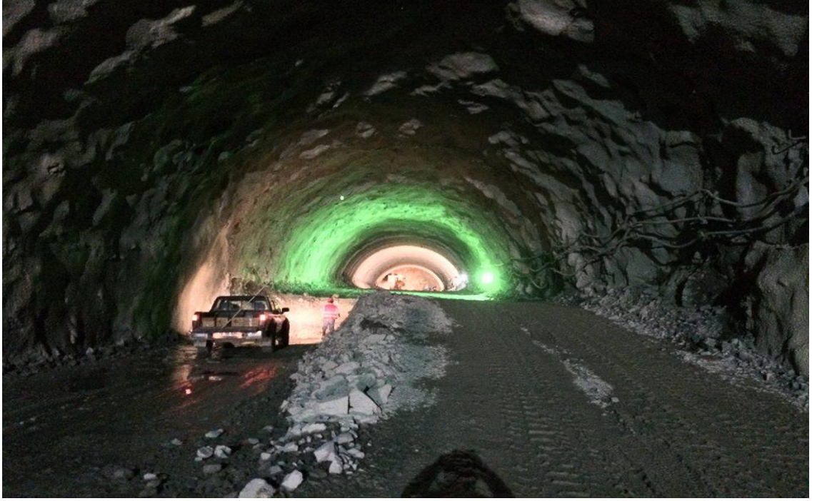
Resim 8.1. A 1 sınıfı sağlam kayayı gösteren ve püskürtme beton ile kaplanmış çelik hasırsız ve iksa desteksiz geçilen tünel birimi
