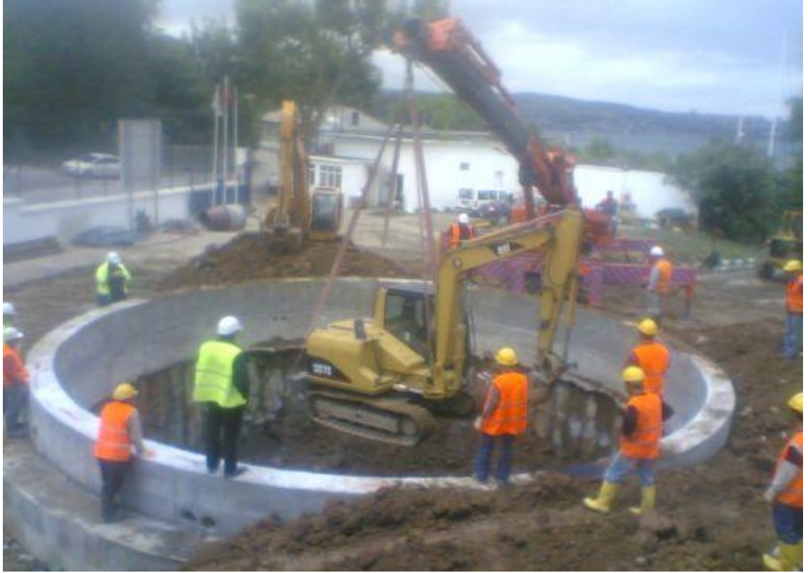
Resim 3.2. Mecidiye İstasyonu şaft kademe kazılarında bir görünüm
