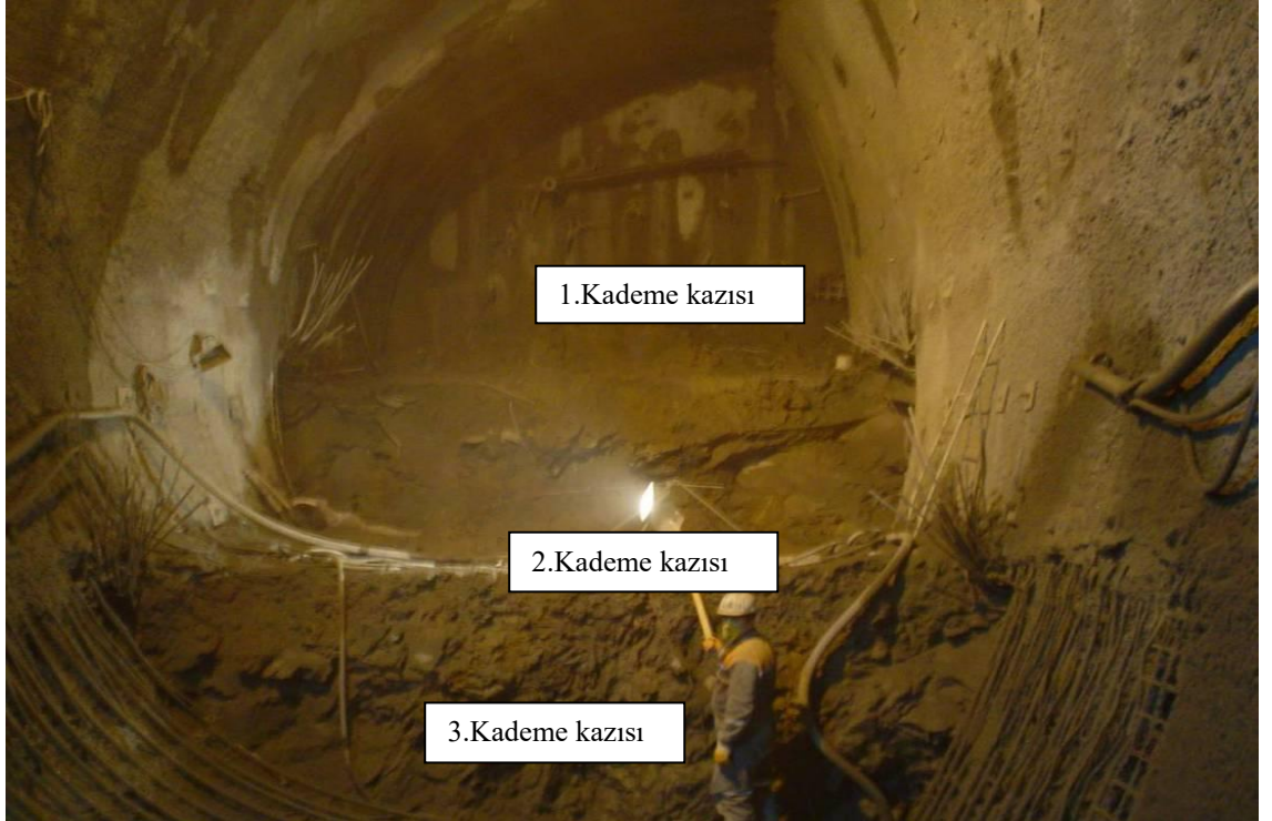
Resim 8.12. Zemin birimlerinde 1,2,3 kademe kazıları
