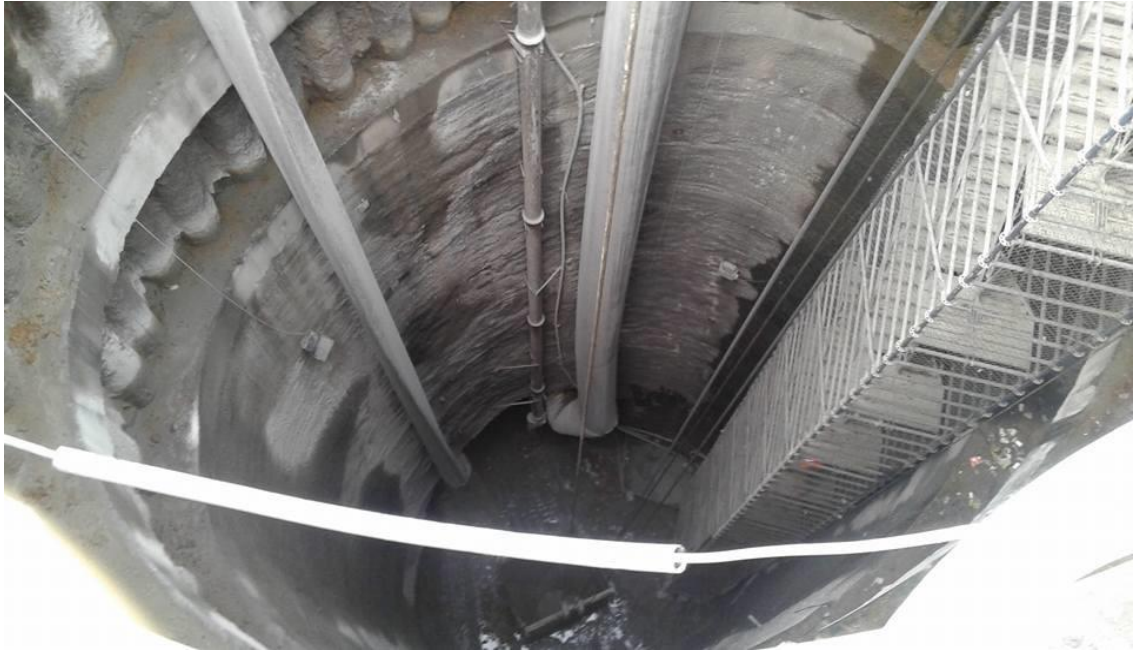
Resim 3.3. Mecidiye İstasyonun biten şaft kazısı ve Mecidiye tarafından Belediye tarafına delme tünelinin yapımına başlanması
