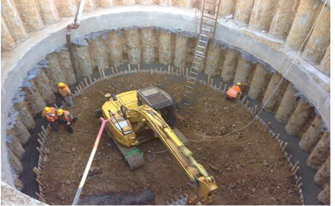
Resim 3.1. Belediye İstasyonu şaft kademe kazısı görünümü
