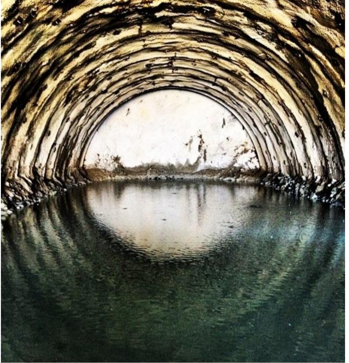
Resim 8.5. B tipi tünel zeminine ait 1. kat çelik hasırlı, kafes iksalı ve püskürtme betonlu geçilen birim
