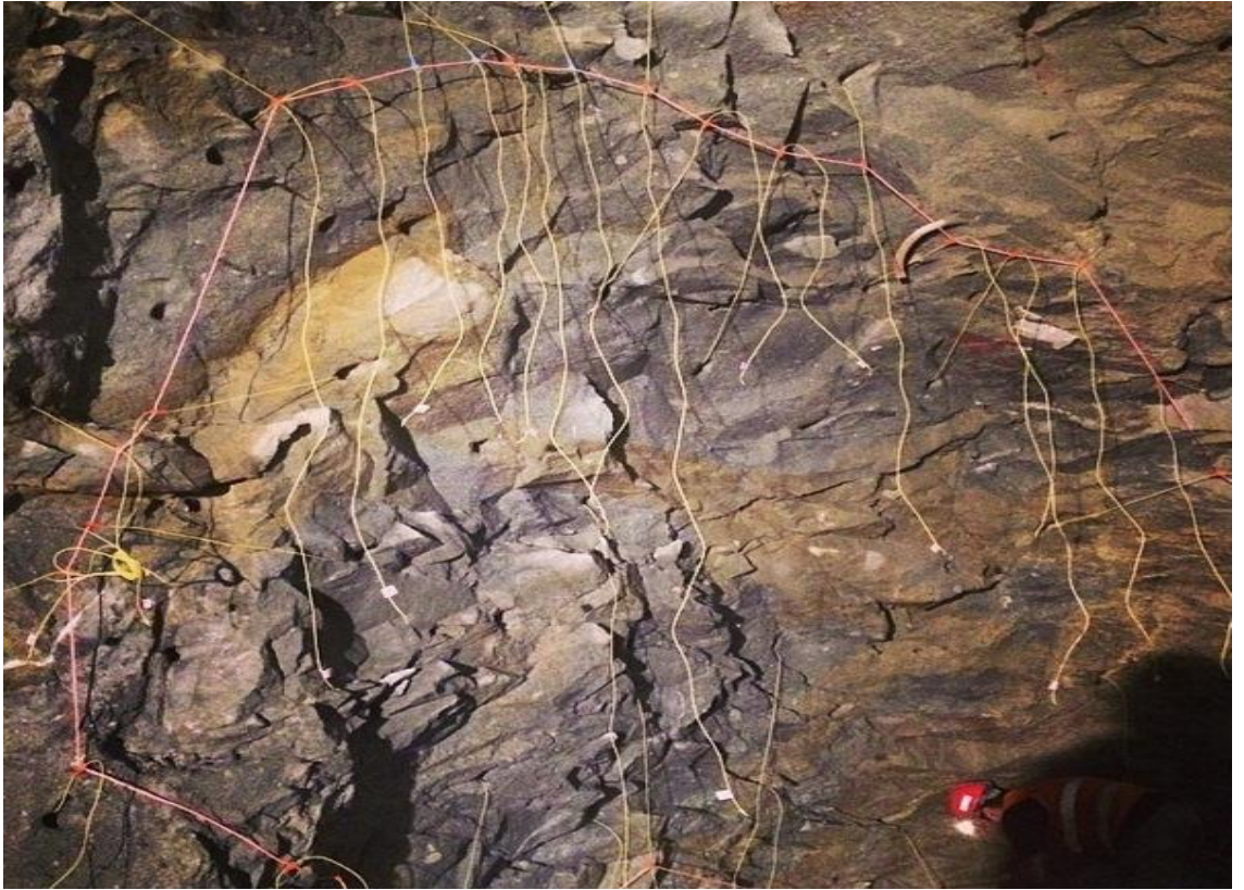
Resim 8.2. A 2 tünel zemininde patlama ile ilerme yapılan tünel aynası
