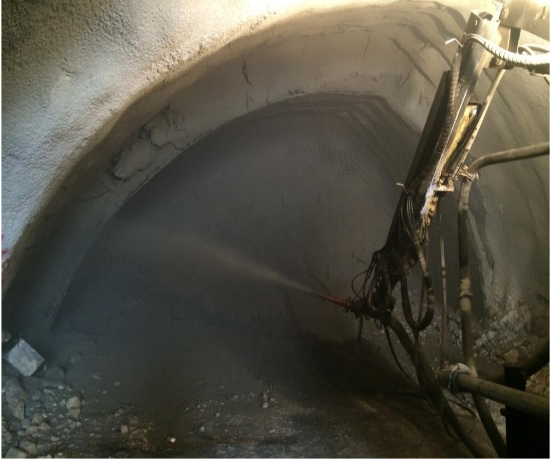
Resim 8.8. Püskürtme beton uygulaması ve 2. kat çelik hasır uygulaması
