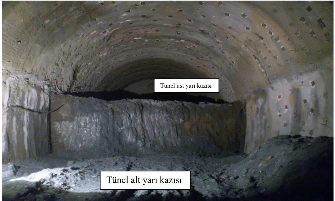
Resim 8.11. Tünel kazı aşamasında tünel üst yarı ve alt yarı kazıları
