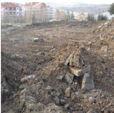
Şekil2. Temizliği yapılan hafriyat toprağı
