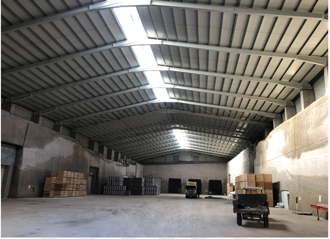
Resim 5.1 Loca giriş ve koridor bölümündeki çatı kaplaması
