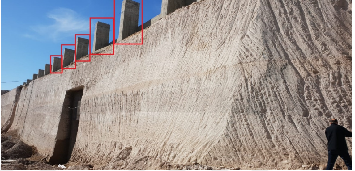
Resim 3.2 İnşa edilecek çatıya ait ayaklar
