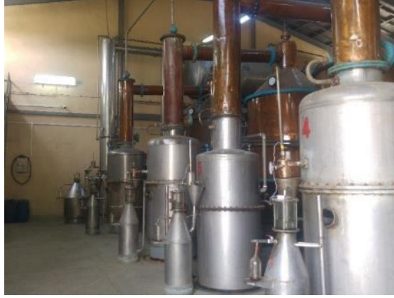
Şekil 7. Gül yağı fabrikası, alt kottan genel görünüm (Kişisel Arşiv, 2018)
