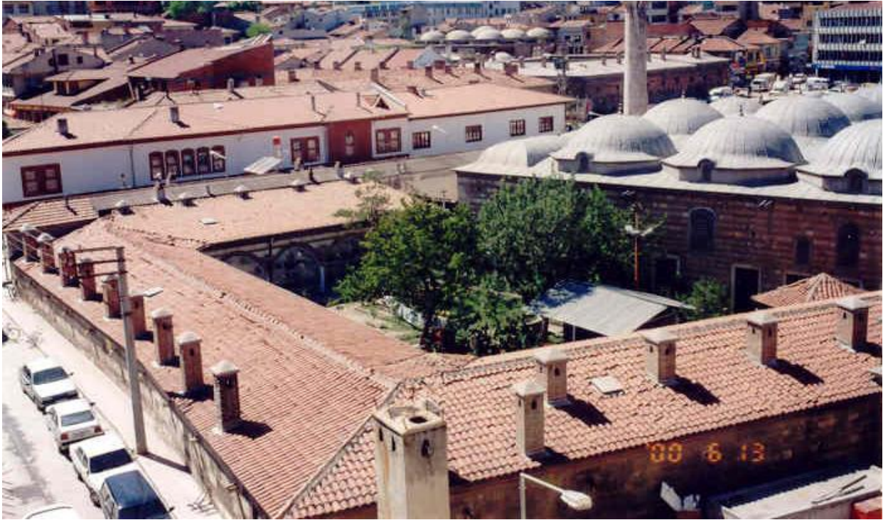
Şekil 4-a: Nasrullah Cami Güneyinde Yer Alan Mürşid Medresesi / Tepeden Görüntümü
