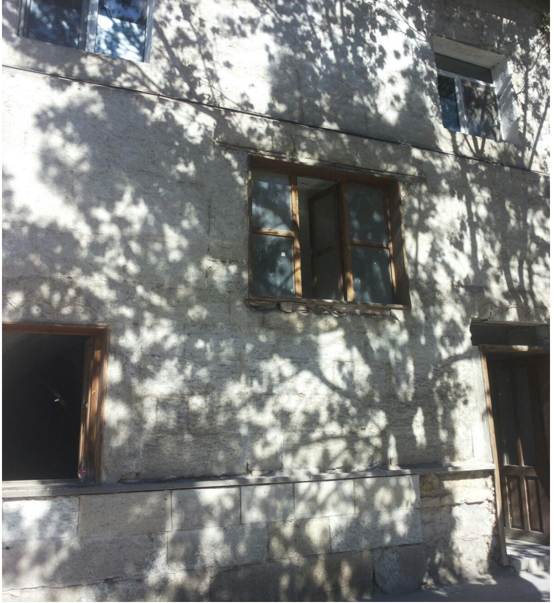
Ek-15. Avanos Bayır Mahalle Caminin Altındaki Mektebin Bir Diğerkapısı 289
