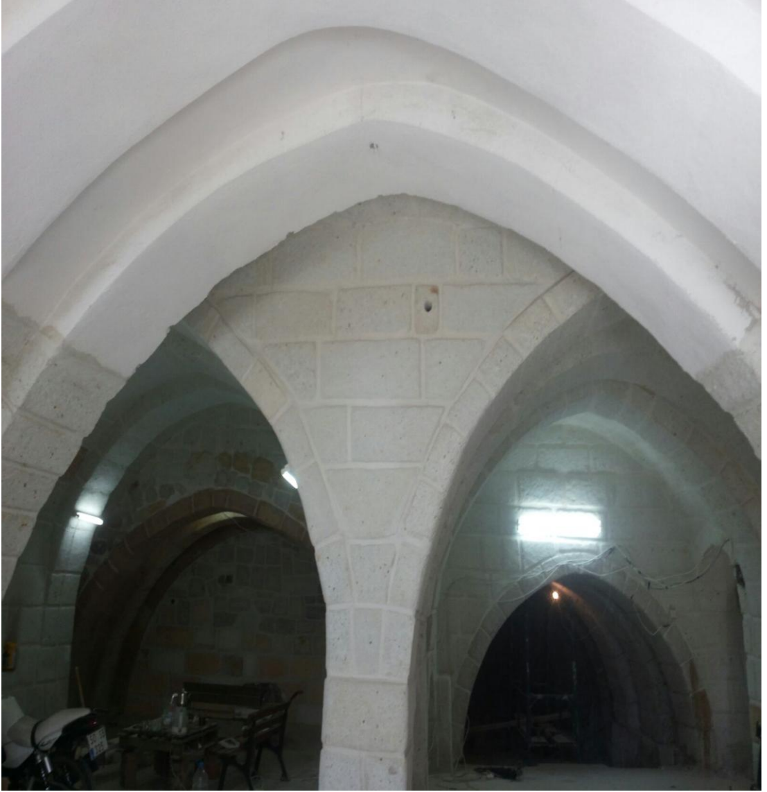
Ek-16. Avanos Bayır Mahalle Caminin Altındaki Mektebin Restorasyon Hali 290
