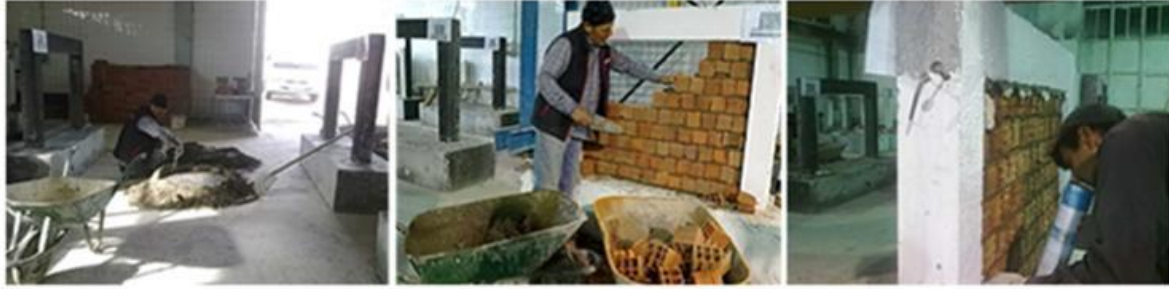
Şekil 3. Duvar örümü aşamaları
