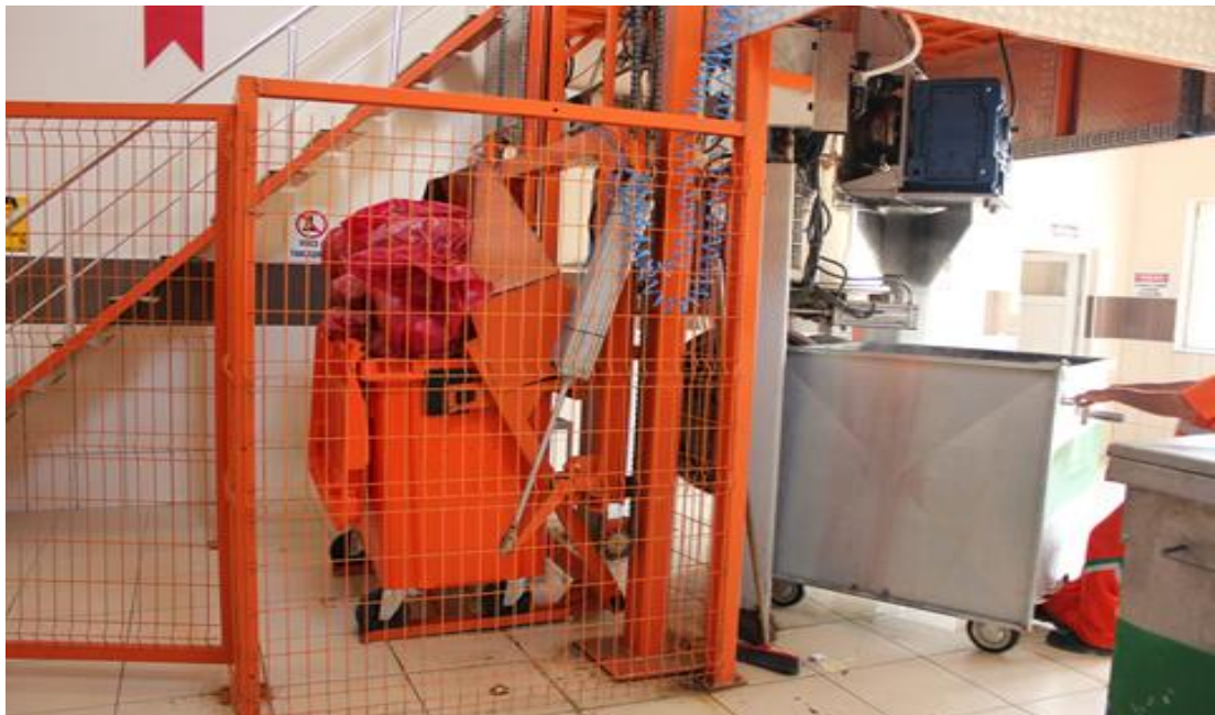
Resim 6. 8. Tıbbi atık sterilizasyon tesisi yükleme asansörü (orijinal resim)
