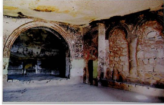
Resim 3.55. Vaftizci Yahya Kilisesi, Orta Nef, Güneydođuya Bakış
