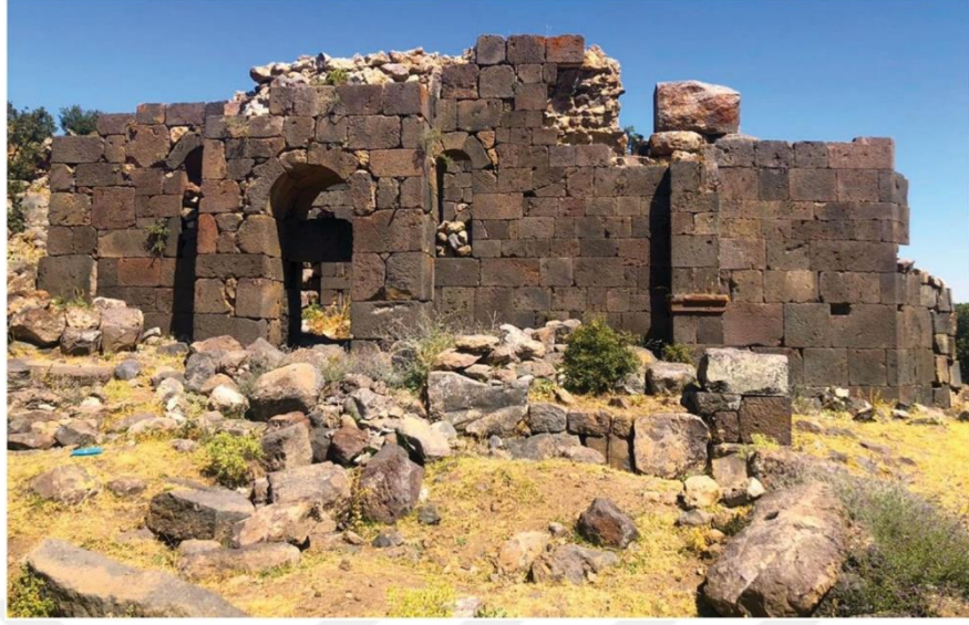
Resim 2.14. Kara Kilise, Güney Cephe
