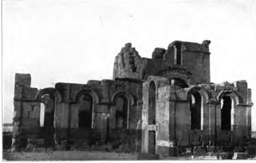
Resim 4.89. Tomarza'daki Panagia Kilisesi, Güneyden Bakış (Rott, 1908: 181)
