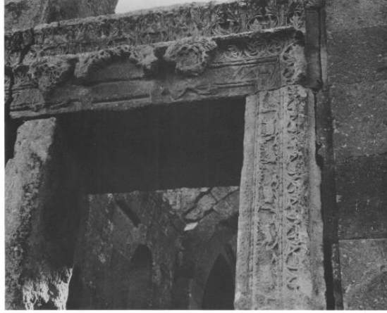
Resim 4.90. Tomarza'daki Panagia Kilisesi, Batı Haç Kolu, Kapı Lentosu
