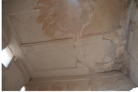
Resim 3.51. Üzümlü Kilise, Kuzey Nef, Tavan Düzenlemesi
