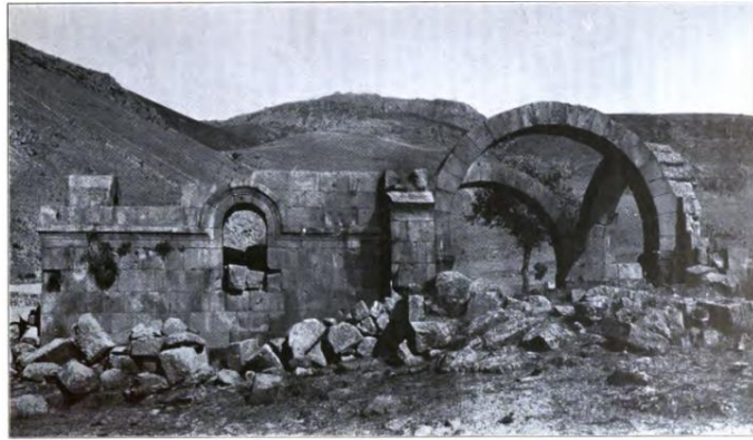
Resim 3.24. Gereme Çanlı Kilise Güney Cephe
