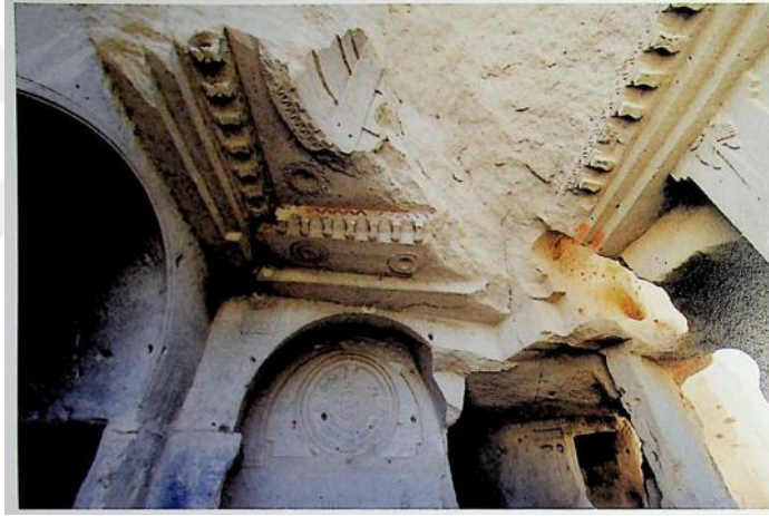
Resim 4.75. Kubbeli Oda, Güney Yönüne Bakış
