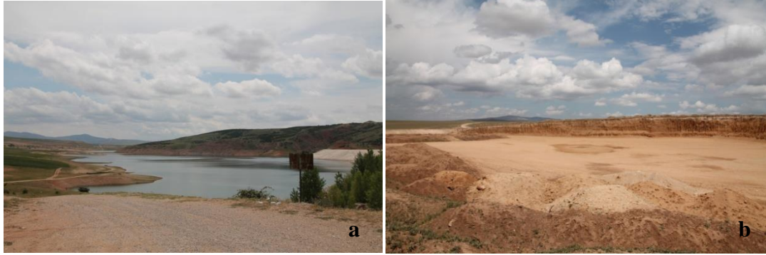
Şekil 37: Boğazlıyan-Çandır arasında bulunan Uzunlu Barajı (a), Boğazlıyan'da yapım aşamasında olan baraj (b).
