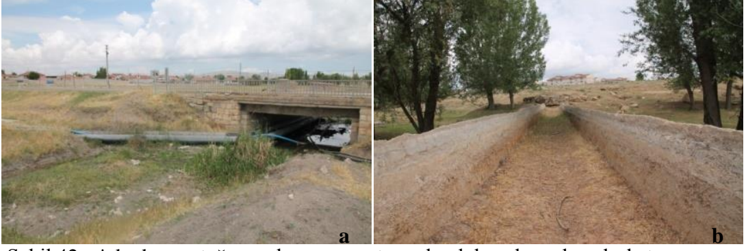
Şekil 42: a' da dere yatağının akış yönüne ters olarak kurulmuş borularla taşman su hattı, (b) su kanalı.
