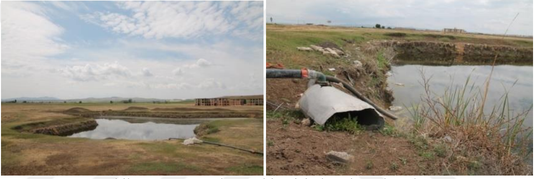
Şekil 43: Yapay göl ve göl içerisinde sulama boruları
