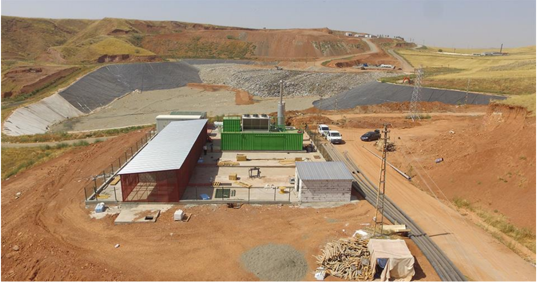
Resim 5.1. Sivas Belediyesi katı atık düzenli depolama tesisi [71]
