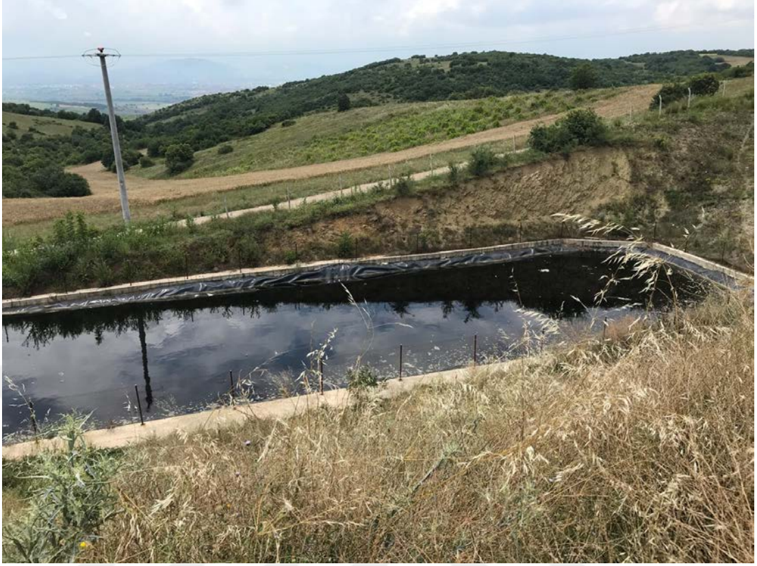
Resim 5.2. Sızıntı suyu havuzu
