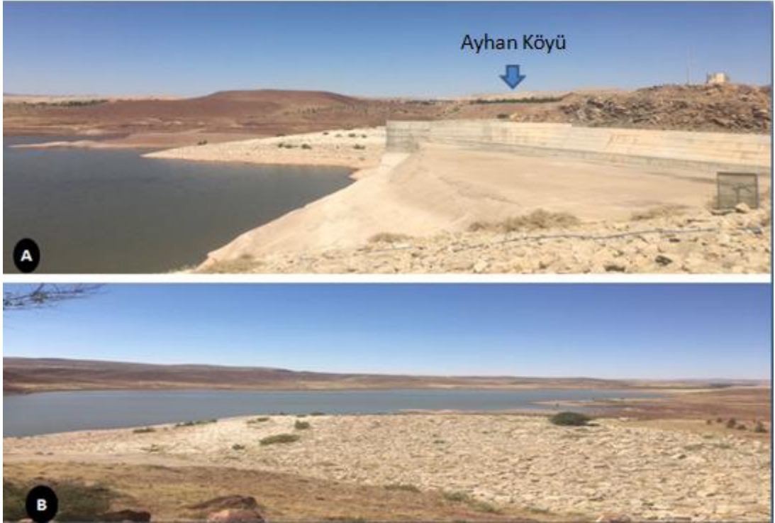
Şekil 11. Ayhan Barajı ve Ayhanlar köyüne bakış
