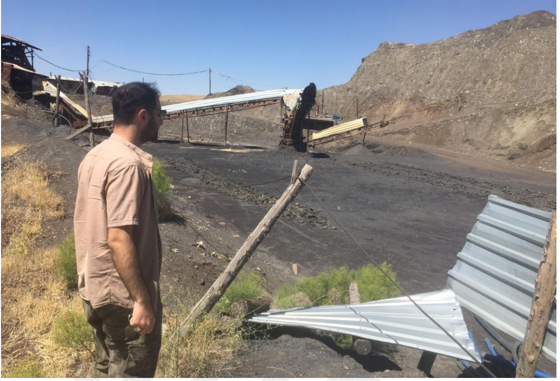
Şekil 26. Gümüşyazı köyü eski, kömür işletmesi
