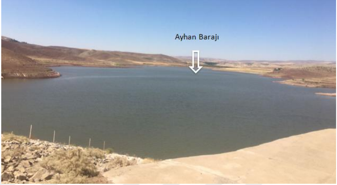
Şekil 10. Ayhan Barajı (Ayhanlar köyü)
