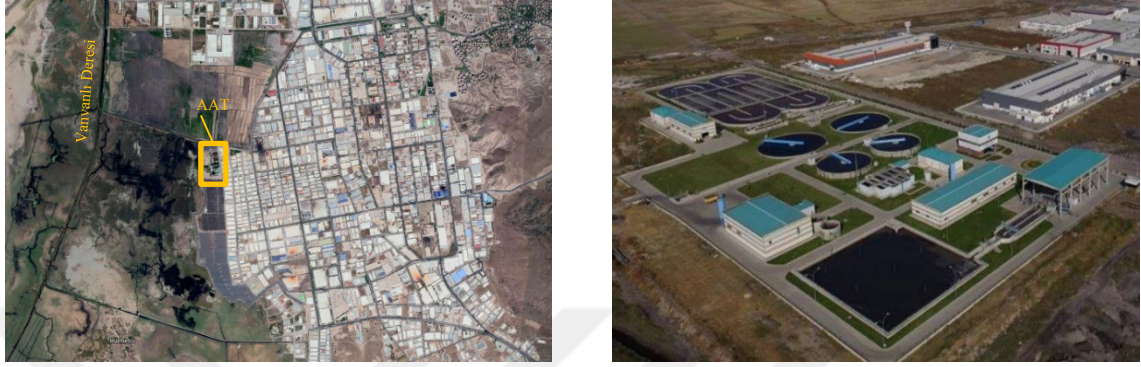
Şekil 5. Kayseri OSB Atıksu Arıtma Tesisi (AAT)'nin görünümü
