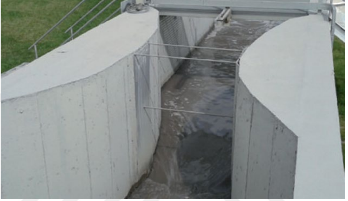
Şekil 8. Giriş debi ölçüm sistemi: Parshall savağı ve ultrasonik seviye sensörü. [36]
