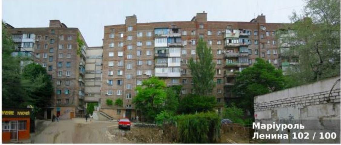
Şekil 1. 1 Alkali aktif cüruftan yapılmış konut binaları, Ukrayna [16]
