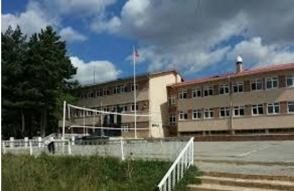
Resim 2. 8. Pamukpınar Köy Enstitüsü Binasının Güncel Kullanımı
