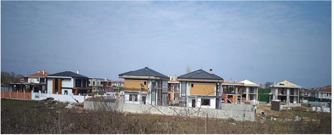
Şekil 62. Şile’de yapımı devam eden ikinci konut inşaatları (Kumbaba Mahallesi)
