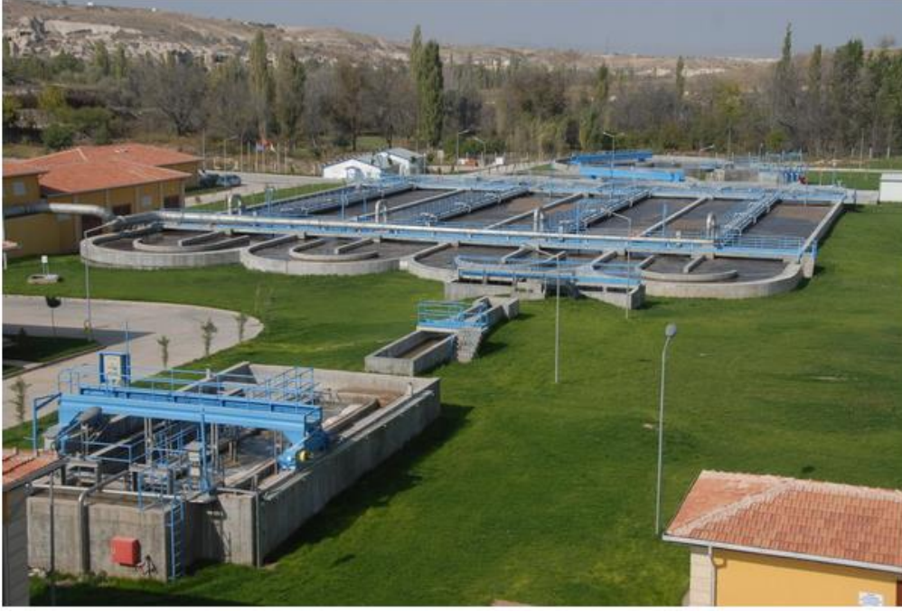
Şekil 3. Atıksu arıtma tesisinin üniteleri
