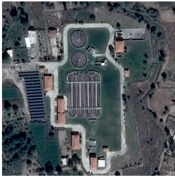
Şekil 2. Atıksu arıtma tesisinin genel görünümü
