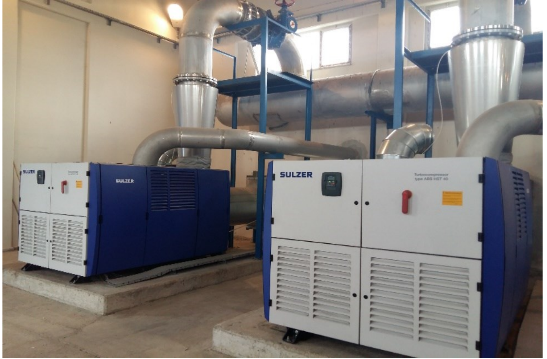
Şekil 3.7. Yeni nesil manyetik yataklı turbo blower [6]
