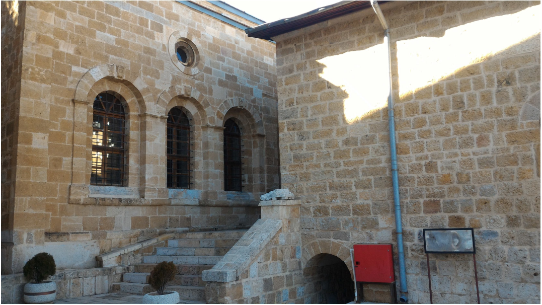
Ashabü'l-Kehf Camii ve Paşa Çardağı
