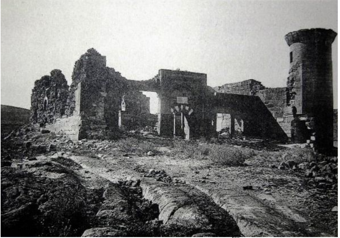
Resim 2.1 Barsama Köyü Camii (1954) 598
