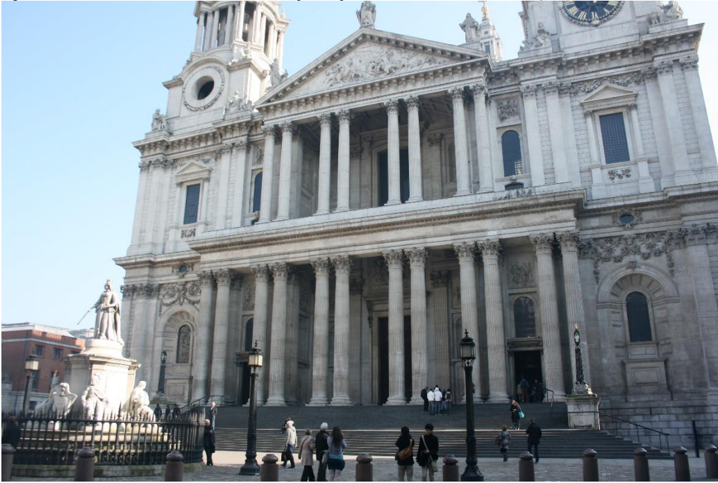
Şekil 3. St. Paul Katedrali Batı Cephesi
