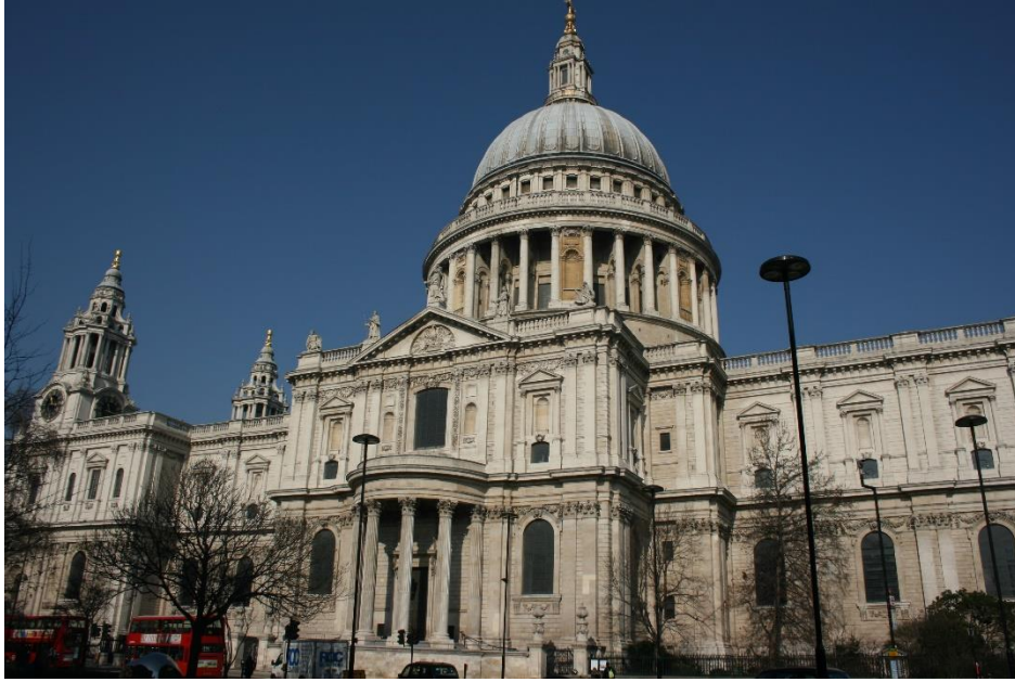
Şekil 8. St. Paul Katedrali Güney Cephe
