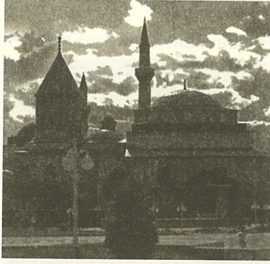
Resim 1: Mevlânâ Mazumesi görünüm.
