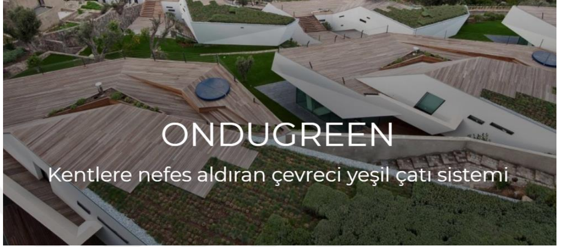
Fotoğraf 4.9. Yeşil Uygulama (Onduline Örneği)
