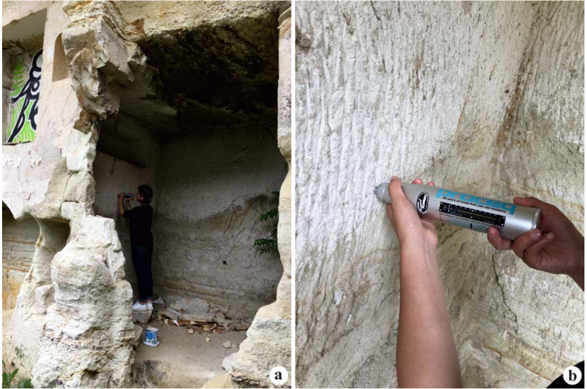
Resim 3.2 Schmidt çekici ile arazide yüzey sertliğinin belirlenmesi
