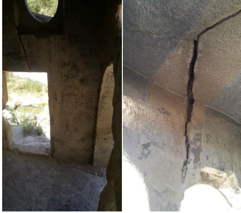
Resim 4.7 204 nolu odad tavan ve duvarında yer alan açıklığın genel görünümü
