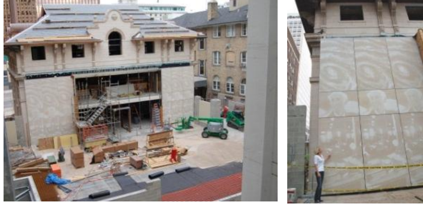
Şekil 38. Taş Bünyeye Lazer Aşındırma ile Dış Cephe Kaplama. Salt Lake City, Amerika (Web 28).
